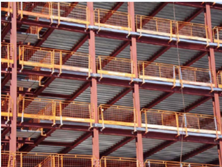
Рисунок 1.5. Сборные защитные ограждения по периметру стального каркаса
