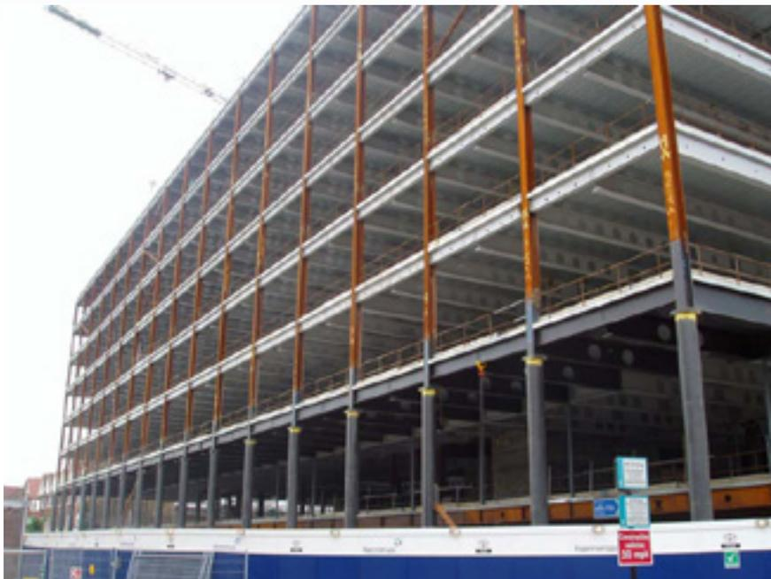
Рисунок 3.2. Большепролетные перфорированные балки в проекте Bishop's Square
