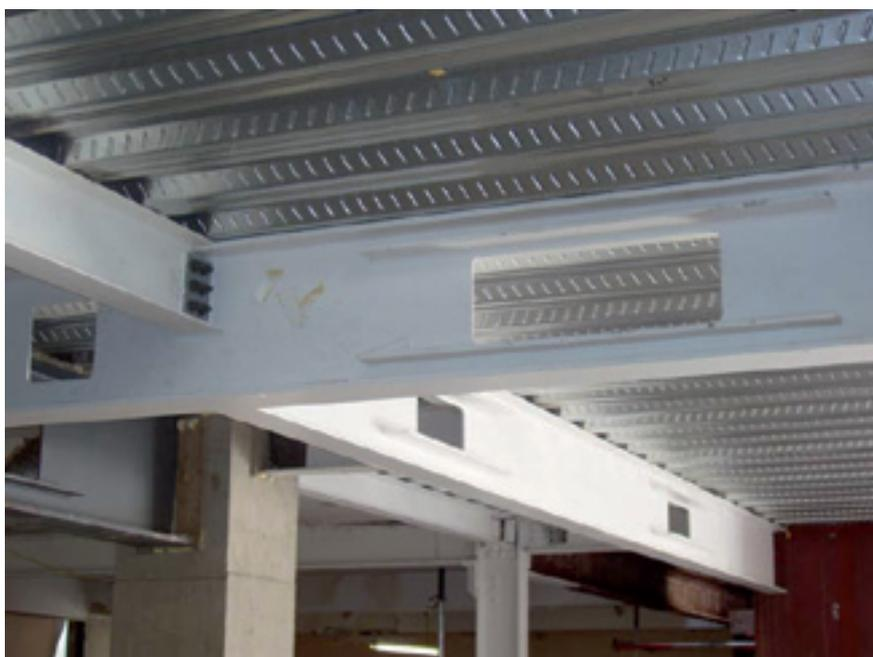
*Рисунок 2.3. Прямоугольные отверстия в композитных балках для прокладки инженерных коммуникаций*
