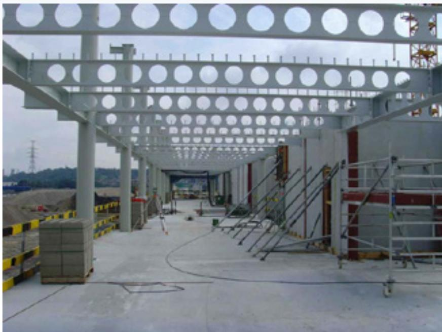
Рисунок 3.10. Перфорированные балки в конструкции здания Arcelor Mittal
