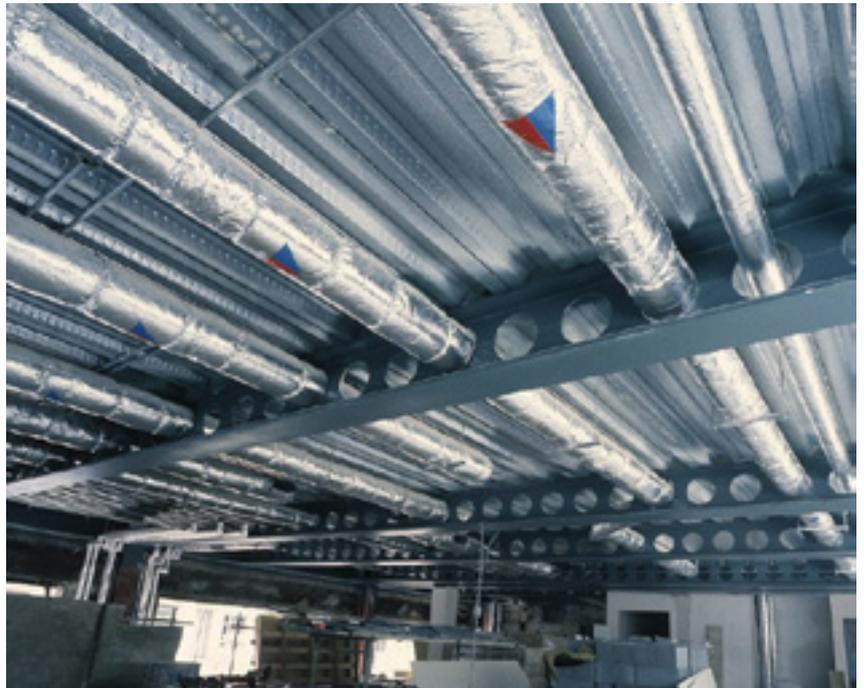
Рисунок 5.8. Большепролетные второстепенные перфорированные балки с регулярно расположенными круглыми отверстиями
