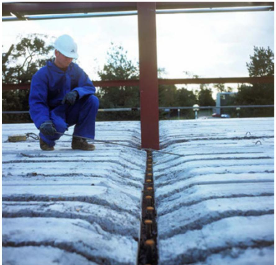
Рисунок 5.12. Устройство композитного перекрытия со сборными железобетонными пустотными плитами – установка соединительных арматурных стержней в специально предусмотренные отверстия
