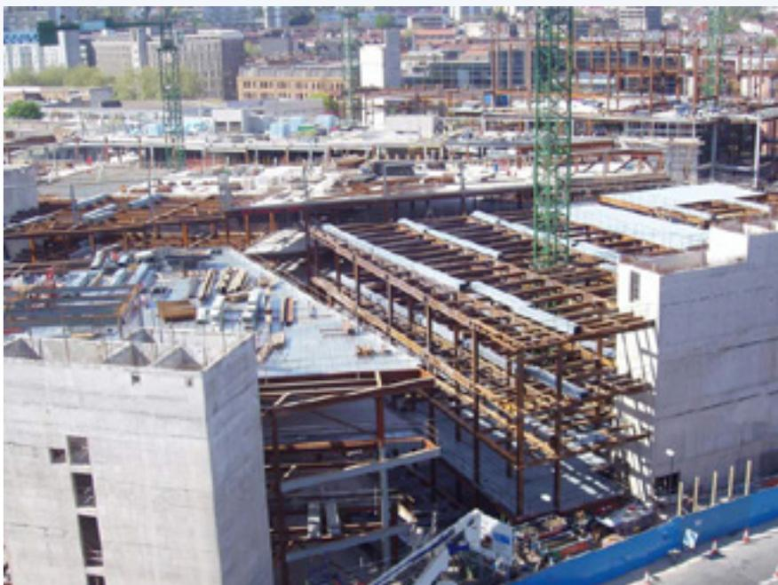
Рисунок 2.1. Высокий темп монтажа стального каркаса и перекрытий увеличивает скорость возведения здания
