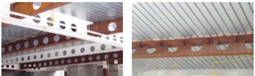
Рисунок 3.7. Различные виды балок в здании «Кингс Плас»
