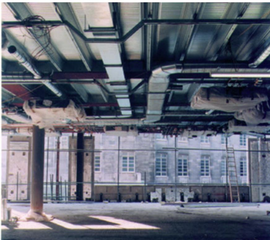
Рисунок 4.14. Прокладка инженерных сетей под перекрытием со встроенными балками
