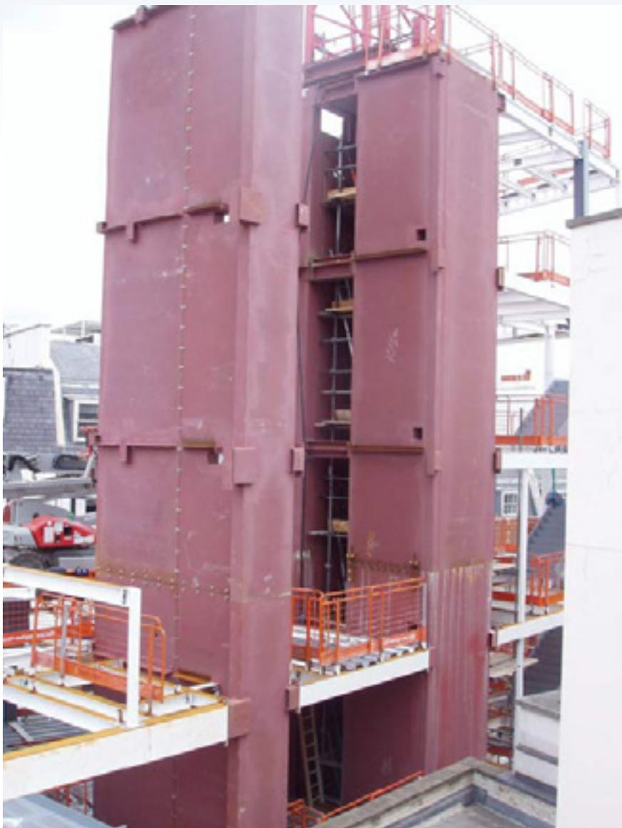
*Рисунок 4.4. Стальное композитное ядро жесткости ускоряет процесс строительства*
