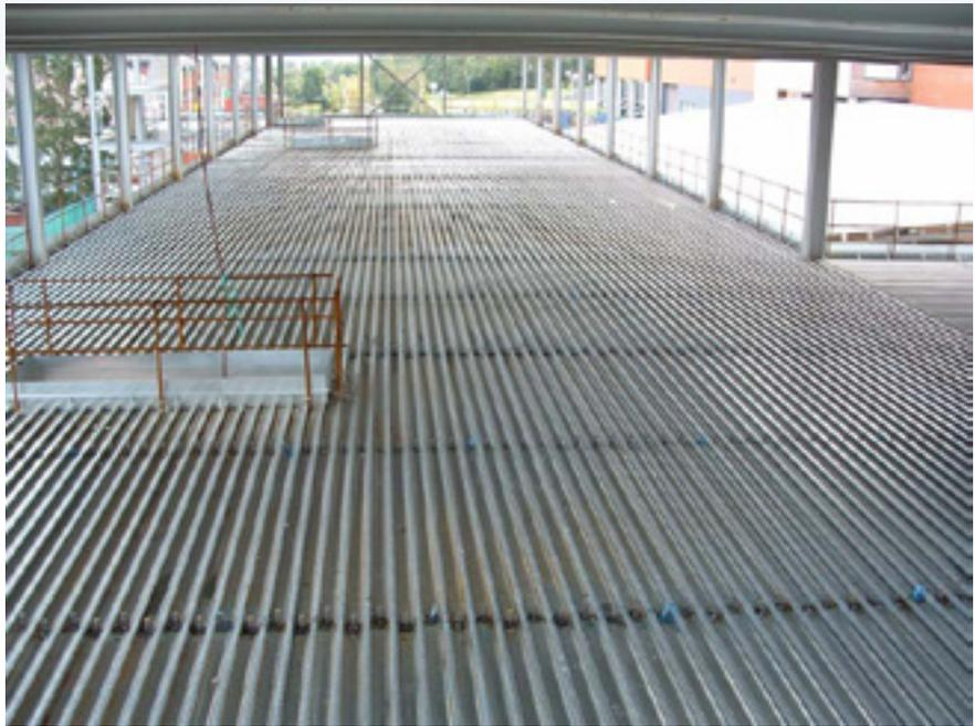
Рисунок 4.11. Композитное перекрытие образует безопасную рабочую площадку на время монтажа
