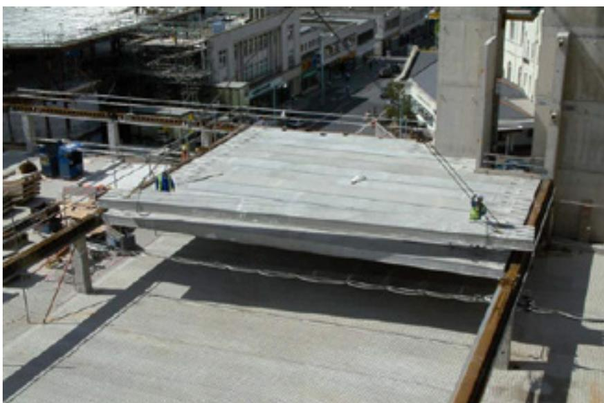
*Рисунок 5.13. Монтаж большепролетных сборных железобетонных плит на стальные балки*
