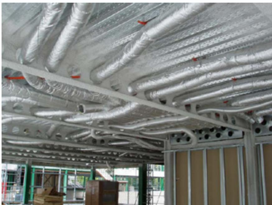
*Рисунок 4.12. Балка с перфорированной стенкой с проложенными трубопроводами инженерных сетей*
