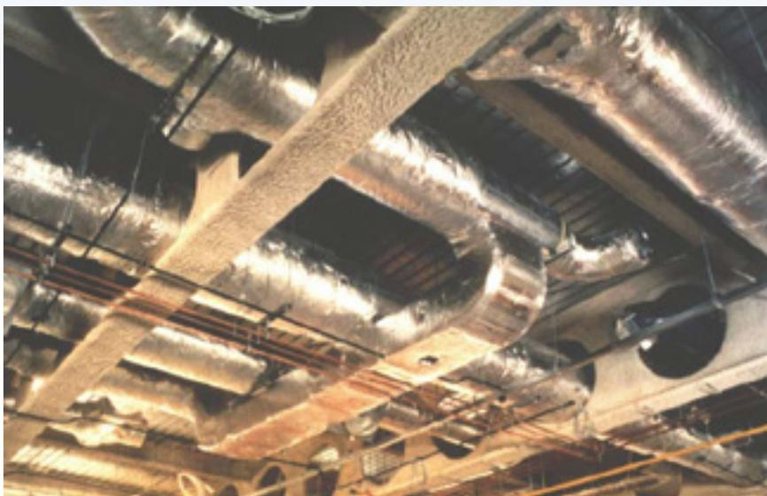
Рисунок 1.3. Инженерные сети, проходящие через отверстия перфорированной балки
