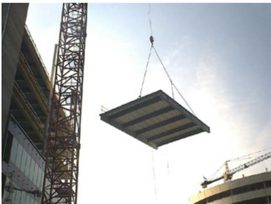
Рисунок 3.9. Сборная панель композитного перекрытия
